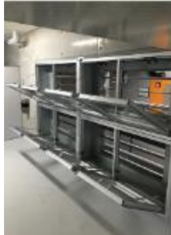
外気導入口 シールド時に湿気の侵入なし
