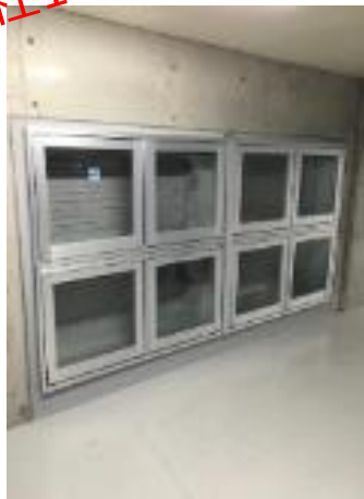
外気導入口 シールド時に湿気の侵入なし
