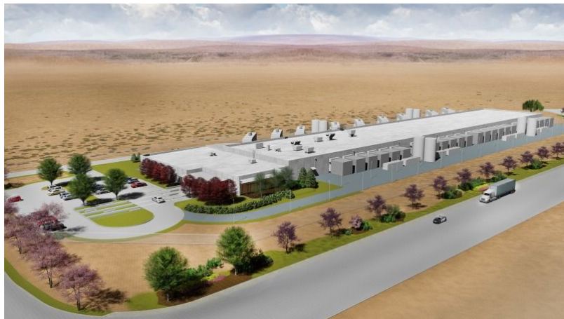
Actapio データセンター
