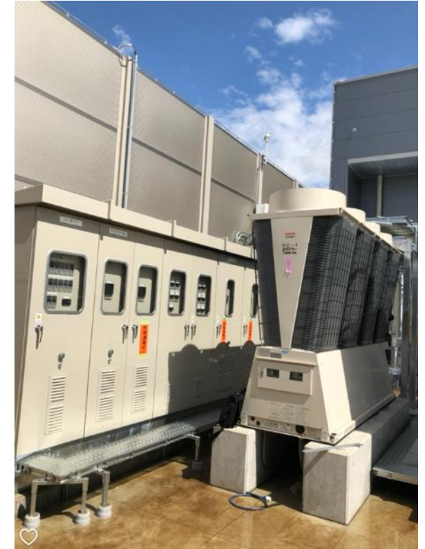
ポンプ制御盤と水冷チラー
