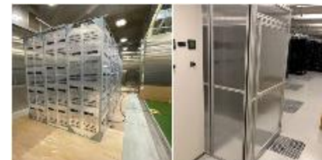
DC in DC by 中空パネル 必要：煙感知器
